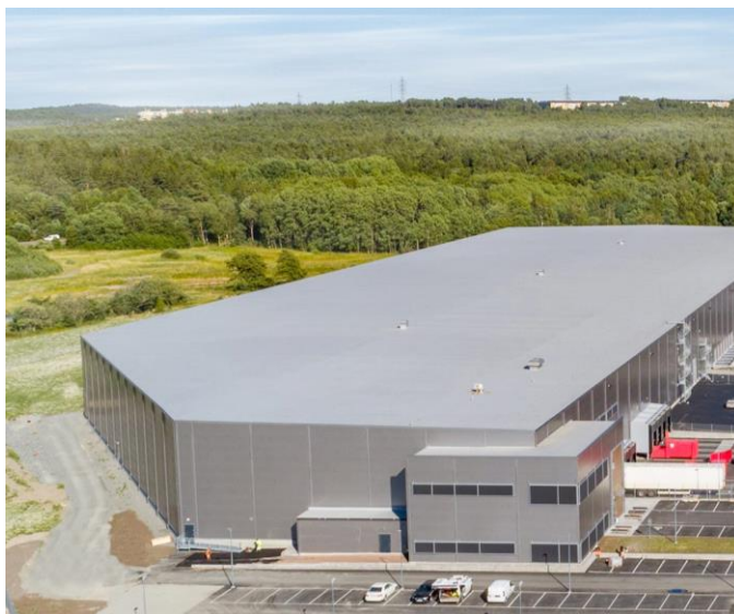
500-kilowattgränsen medför att stora tak som det här inte används maximalt för solel.
